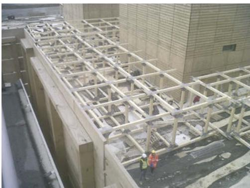
**< Fasi di montaggio della copertura di legno lamellare**
