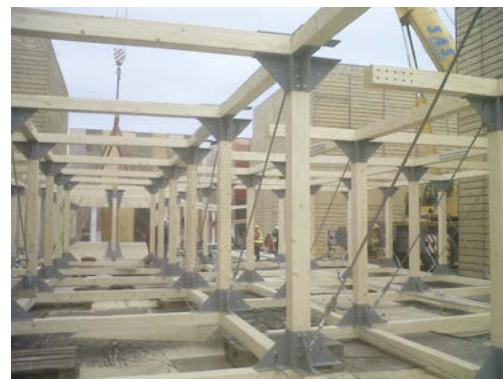
**< Dettaglio strutturale copertura di legno lamellare: gli agganci metallici**
